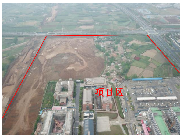
项目区西侧施工现状
