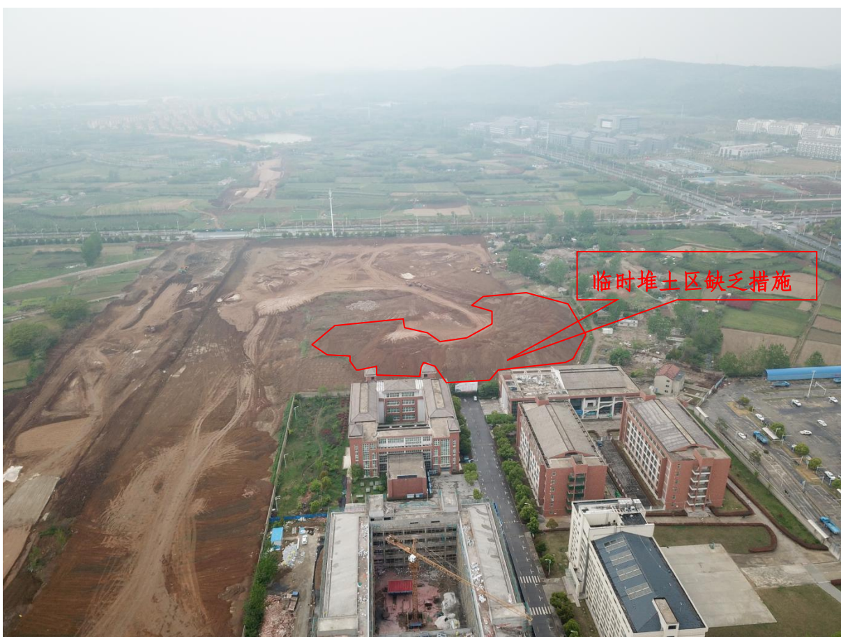
项目区缺乏水土保持措施
