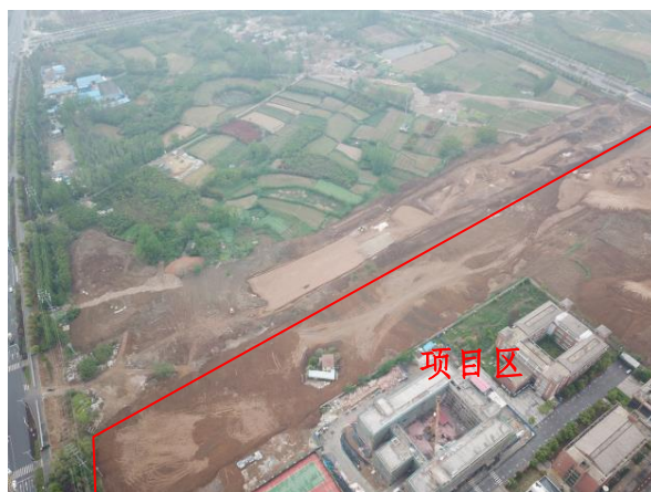
项目区南侧施工现状
