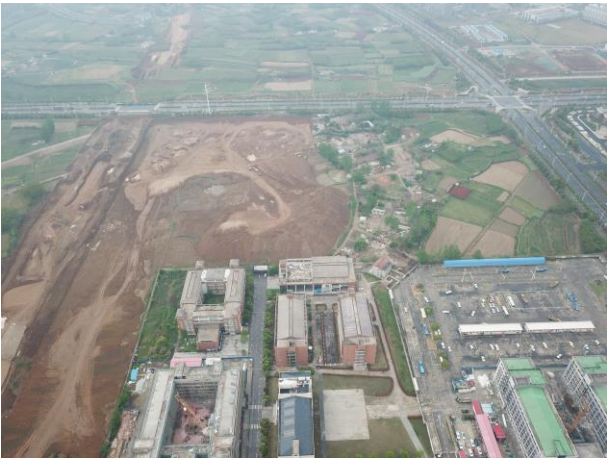
照片 3 西侧西涧路以及现场现状
